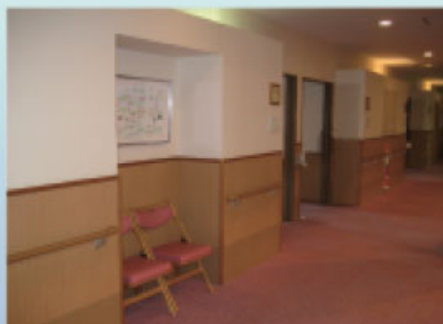
廊下は休憩をしながら歩けるように工夫がされている
